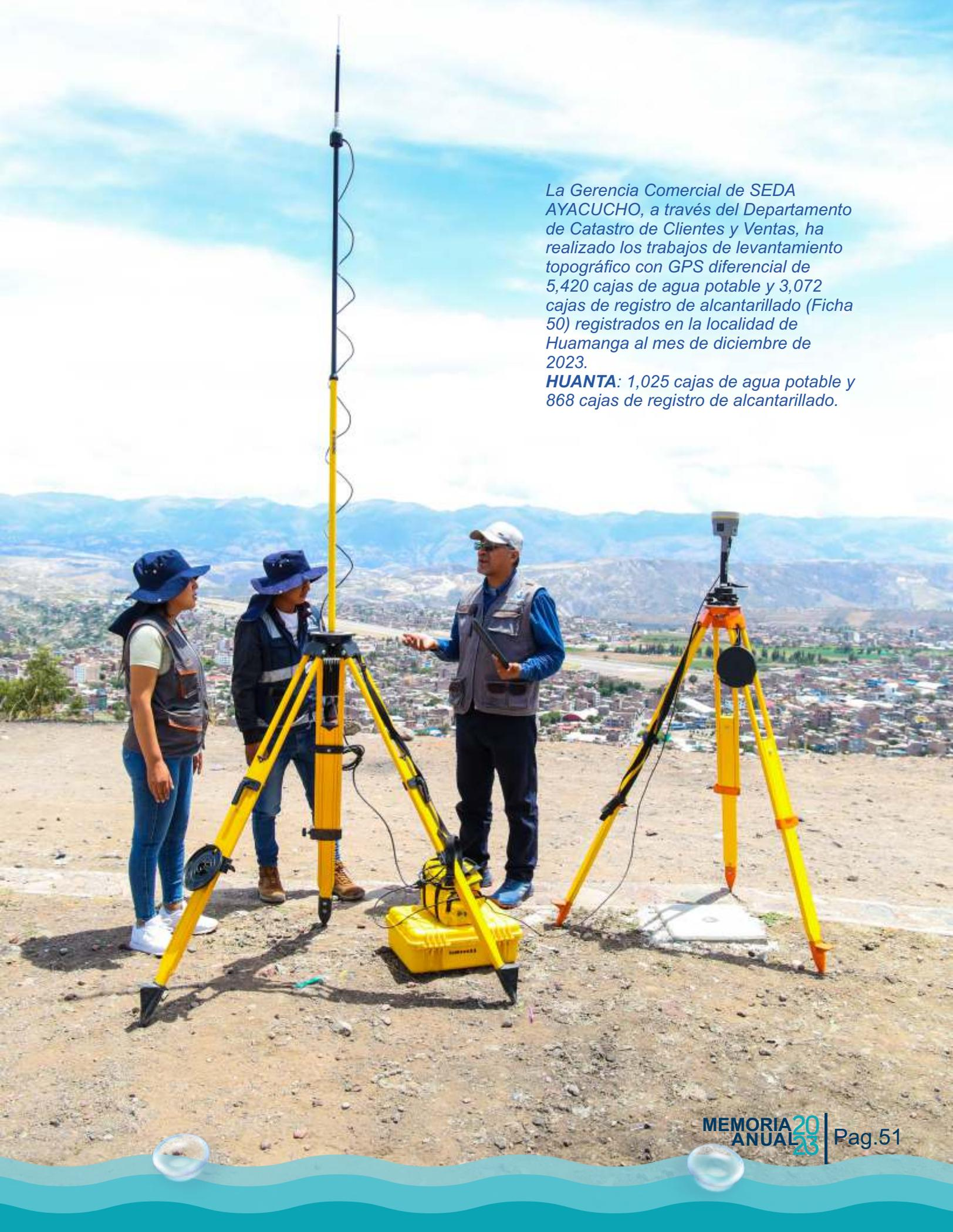
La Gerencia Comercial de SEDA AYACUCHO, a través del Departamento de Catastro de Clientes y Ventas, ha realizado los trabajos de levantamiento topográfico con GPS diferencial de 5,420 cajas de agua potable y 3,072 cajas de registro de alcantarillado (Ficha 50) registrados en la localidad de Huamanga al mes de diciembre de 2023.
