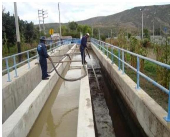
Imagen: Tanques Imhoff Pre- sedimentación PTAR TOTORA
